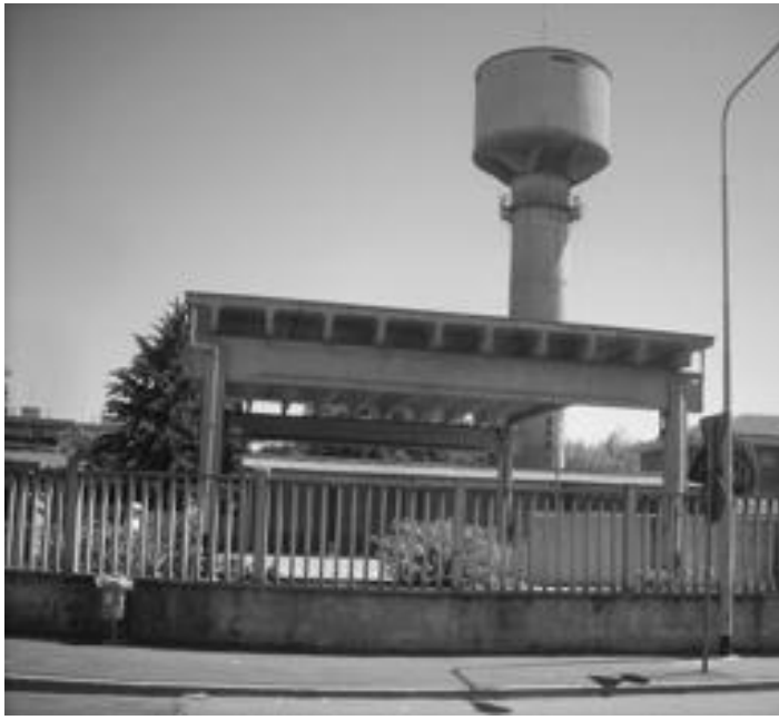
La zona dell'ex Enel: si realizzeranno presto due palazzine da 6 piani ciascuna
